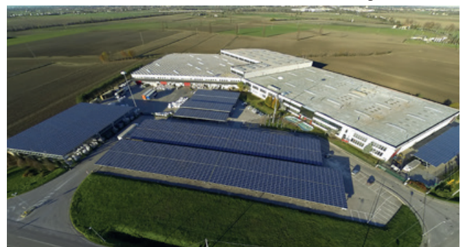
Produktionsstätte mit Blick auf die Photovoltaikanlage
